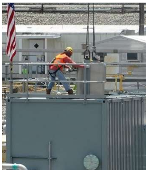
Fig. 3a. TCCR IXC Installation
